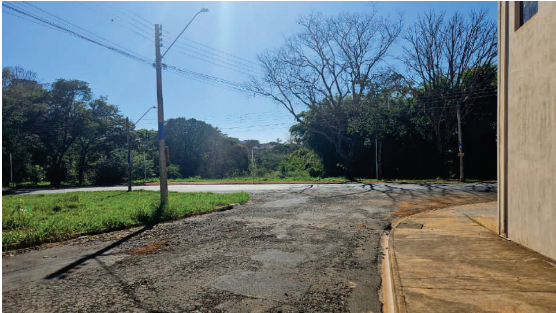
Do lado do Colina Verde, ponte fará esquina com av. Italo Poli, ligando-se à rua Setsuo Murakami
