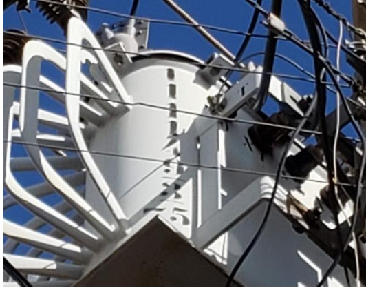
FIGURA 1 – POSTE DE RECEBIMENTO (SEM IDENTIFICAÇÃO)
